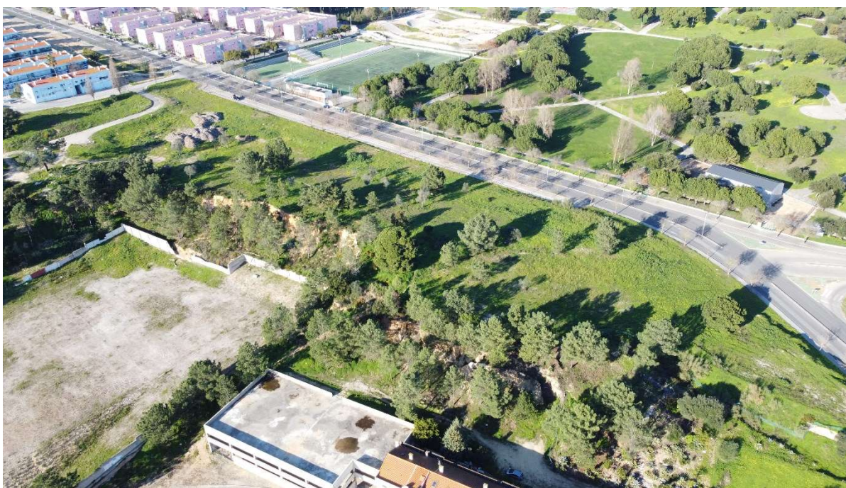
Fotografia A02 (fotografia aérea)
